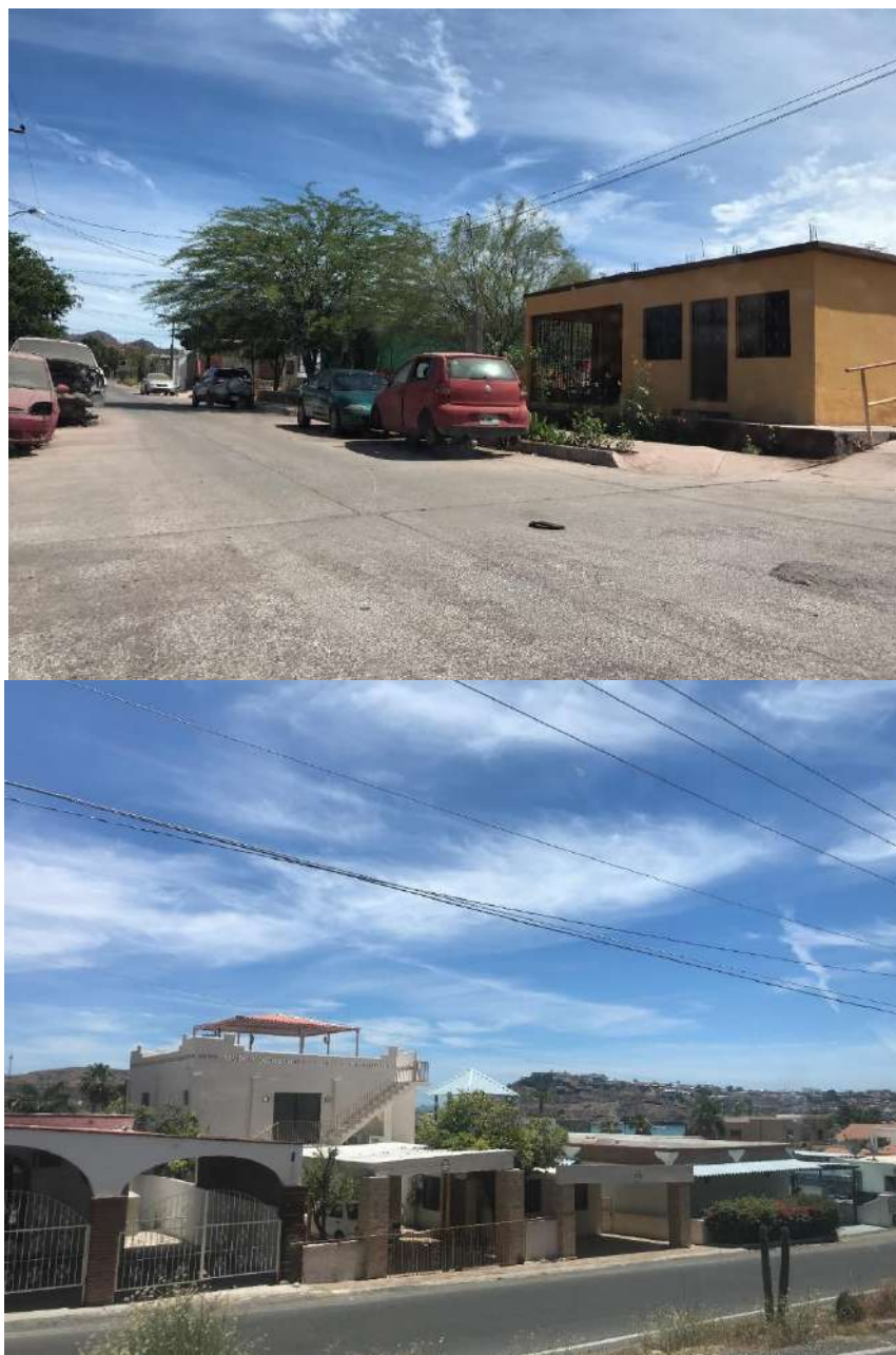
Ilustración 26. Ejemplos de uso de suelo habitacional unifamiliar en Guaymas y San Carlos
